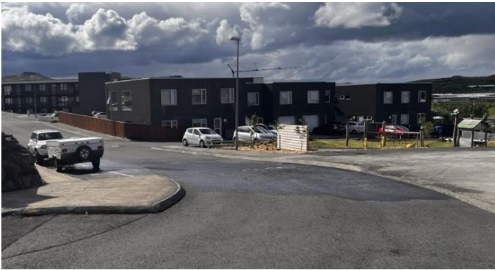
MYND 3 Akbraut þrengd með steiptu eyra við leikvöllinn. Mynd: Berglind Hallgrímsdóttir.
